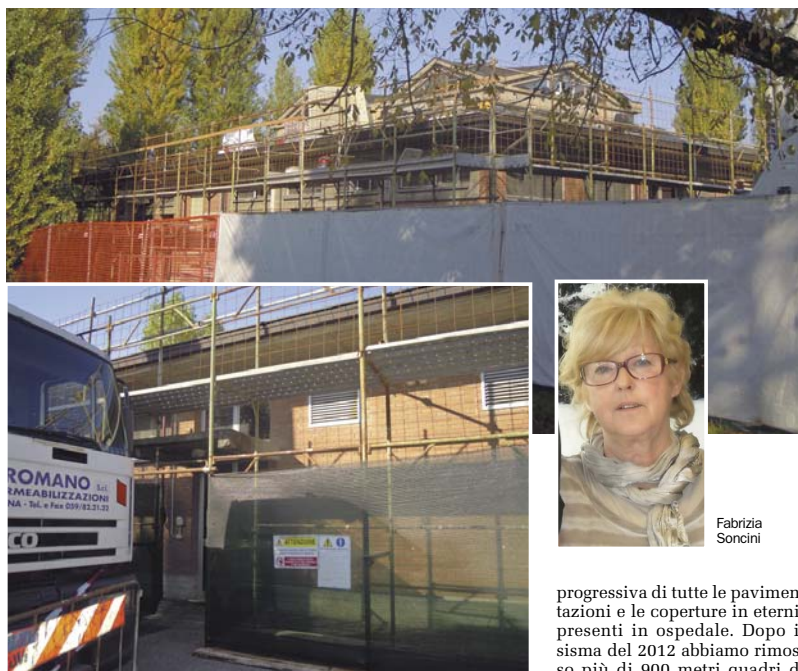
Il cantiere aperto sul tetto dell'edificio che ospita le camere mortuarie del Ramazzini
